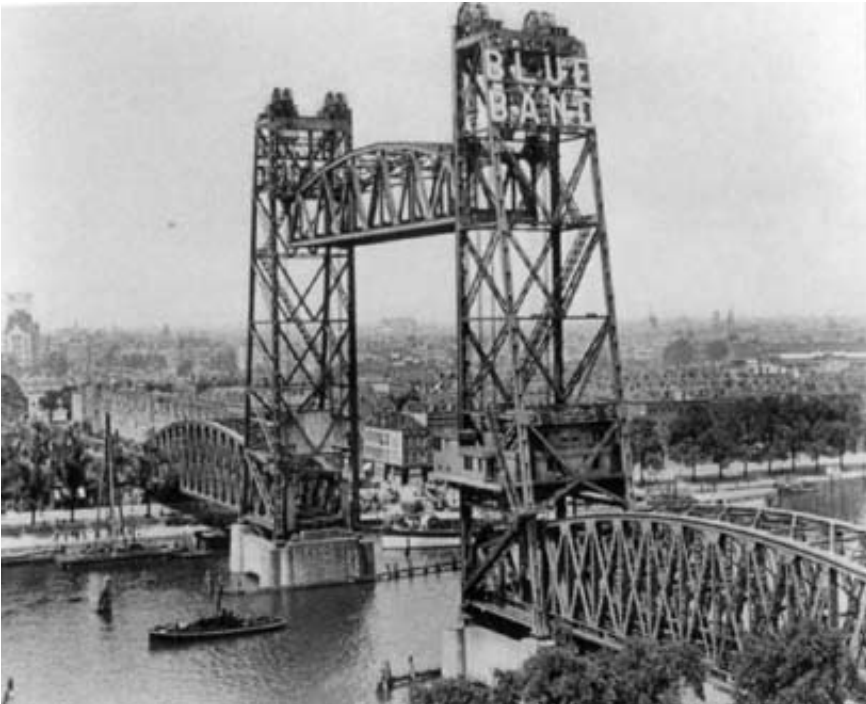
Zicht op de spoorbrug De Hef over de Koningshaven, genomen vanaf de kerktoren aan het Stieltjesplein. Fotocollectie GAR.
