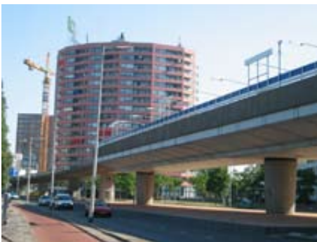
De metrolijn boven de Hillelaan, met op de achtergrond de vernieuwde Hillekop.
