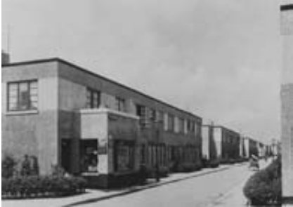
De Kossel II Hyacintstraat: band van glad pleisterwerk ter hoogte van de vensters op de verdieping. Uit: Cusveller (1989).
