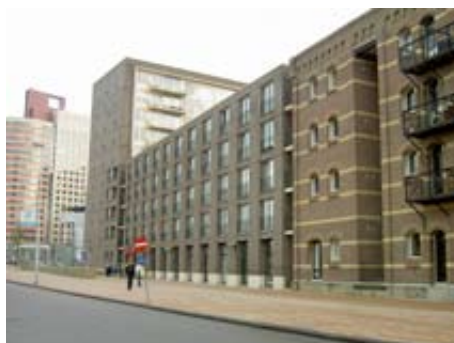
Nieuwbouw aan de Wilhelminakade (Kop van Zuid).
