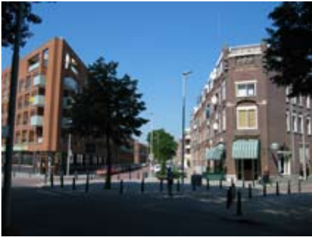
Nieuwbouw en gerenoveerde oudbouw aan weerszijden van de Bloemfonteinstraat (Afrikaanderwijk).
