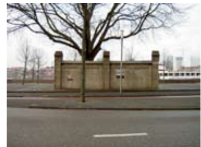
Restant RHV-muur tussen de Koningshaven en de Stieltjesstraat.
