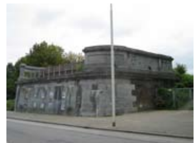
Het bruggenhoofd van de voormalige spoorbrug over de Nieuwe Maas.
