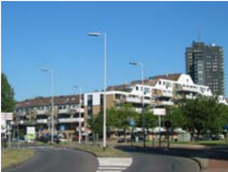
Nieuwbouw ter plaatse van de Dokhaven (Charlois).
