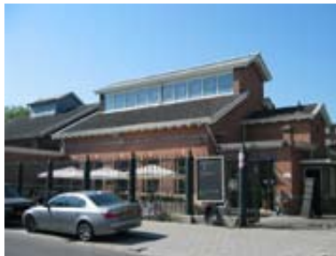
Het Zuidoostelijk Stoomgemaal, nu restaurant aan de Pretorialaan in de Afrikaanderwijk.
