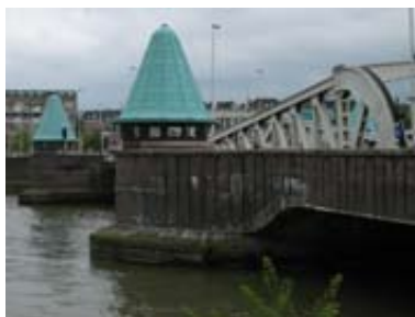
De basculebrug over de Koningshaven.
