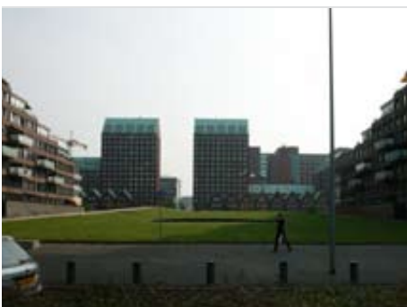
Nieuwbouw aan weerszijden van de Spoorweghaven (Feijenoord).
