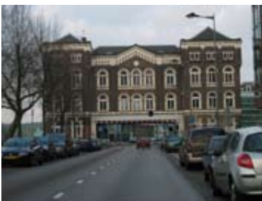
Poortgebouw van de RHV over de Stieltjesstraat.
