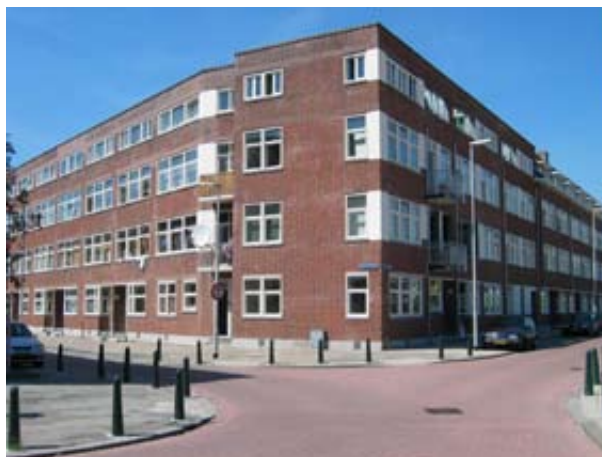
Gesloten straatwanden aan de Borselaarstraat en de Rijsoordstraat.
