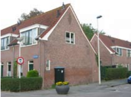
Gerenoveerde woningen in Vreewijk.
