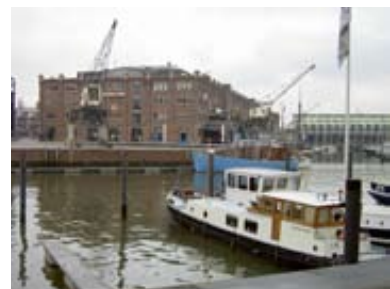
Zicht op het entrepotgebouw 'De Vijf Werelddelen' aan de Entrepothaven en de Binnenhaven.
