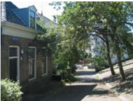
Oud-Charlois: Dijkhuisjes aan de Grondherendijk en de Kaatsbaan.
