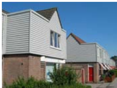
Bloemhof: renovatie, dakdozen.
