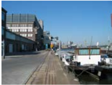
Kade Rijnhaven bij Meelfabriek Latenstein.
