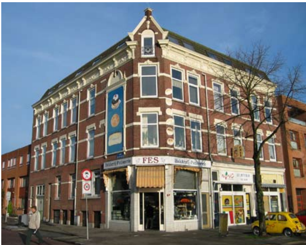
Karakteristiek pand van omstreeks 1900 met een afgeschuinde hoek, gevelbord voor reclame en rijke versiering in stuc. (hoek Paul Krugerstraat en Schalk Burgerstraat).
