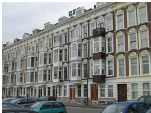
Woningbouw aan de Maaskade.
