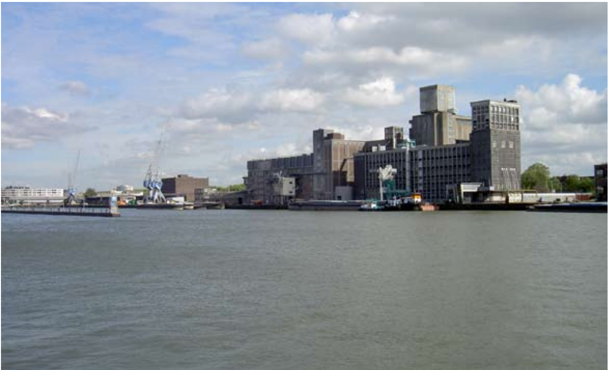
Silo's Katendrecht vanaf de Wilhelminapier.
