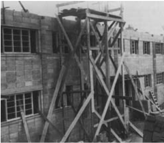
Betondorp Stulemeijer in aanbouw: stapelbouw in beton. Uit: Cusveller (1989) kapt voorzijde (coll. GAR).
