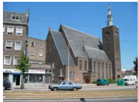
Gereformeerde kerk aan het Breeplein 1. (H. Sutterland jr., 1930).
