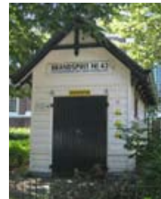
Brandspuithuisje no. 43 Charloisse Kerksingel.
