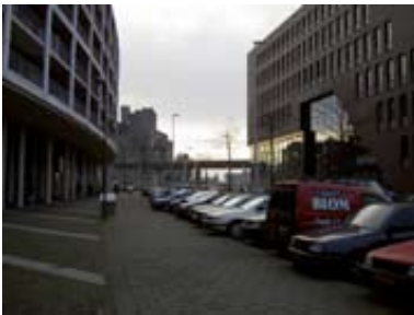
Paul Krugerstraat richting Maashaven.
