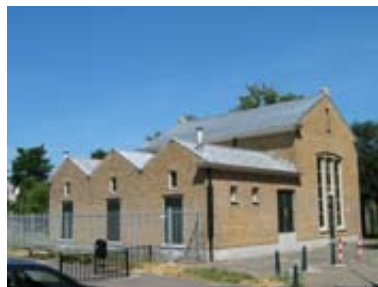
Gemaal aan het Amelandseplein.
